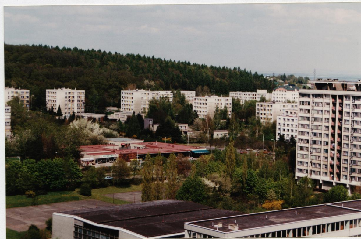
BODOVÉ DOMY POD ĎÁBLICKÝM HÁJEM
